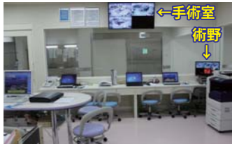
スタッフステーション内部と監視画像モニター
